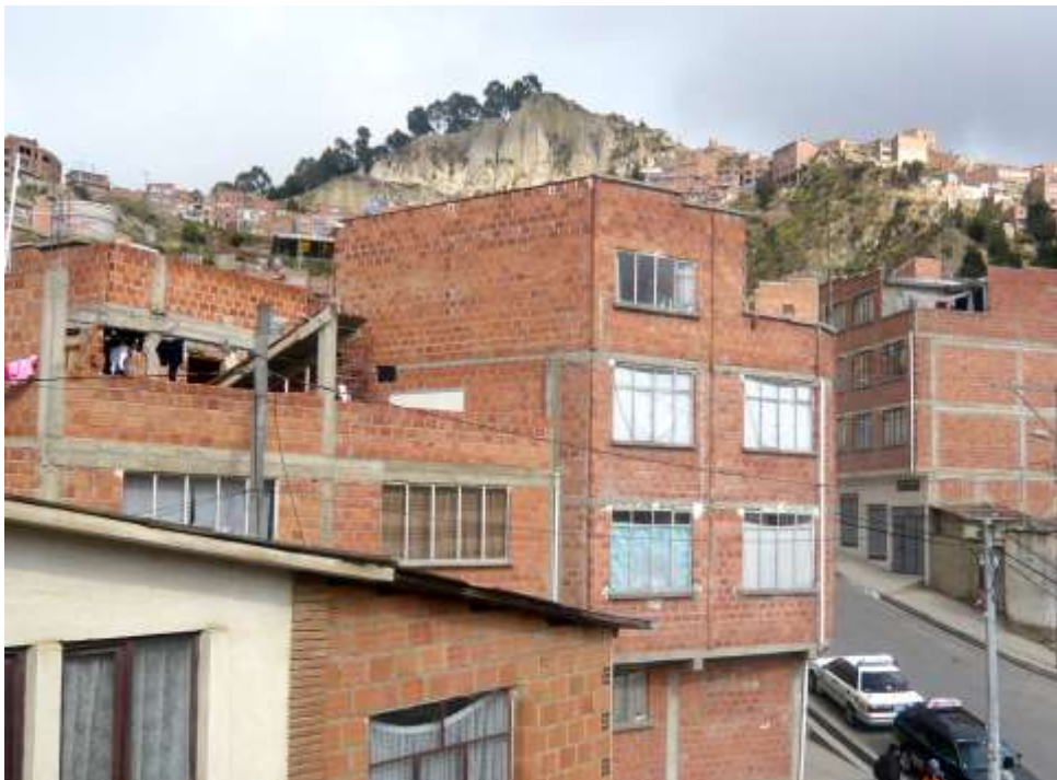
Wohnhäuser in fertigem Zustand
